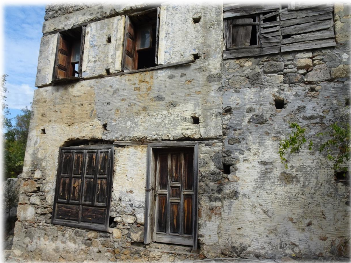
Al het houtwerk aan deze woning is nog steeds origineel.
